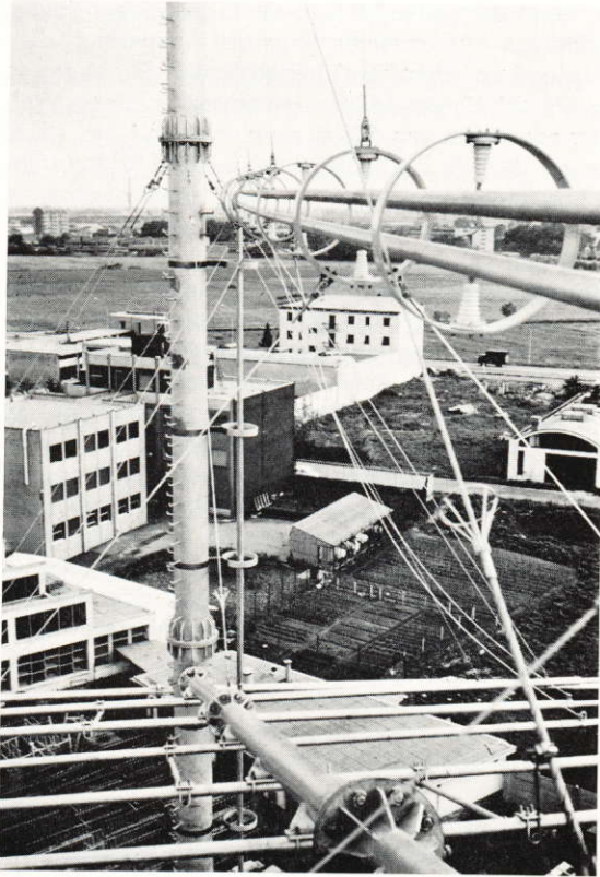
Bild 4 Speiseleitung für den unteren Fächer einer logarithmisch-periodischen Dipolantenne für 5 bis 30 MHz mit einigen Hundert kW Nennleistung. Foto 17 406
