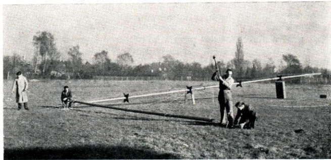
Abb. 5 Montage der Reusenantenne: Auslegen des Mastes und Hilfsmastes Mounting of the cage antenna: Laying out of the mast and the auxiliary mast Montage de l'antenne en cage: Placement du mât et du mât auxiliaire.
